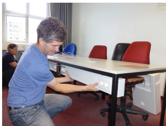
Abbildung 20: Nach Entfernen der alten Lichtwellenleiter verlegen Helma Sendlbeck und Leonhard Hüttinger Kupfer-Netzwerkkabel in sämtliche Kabelschächte und schließen die Kabel an dem neuen Switch an.
