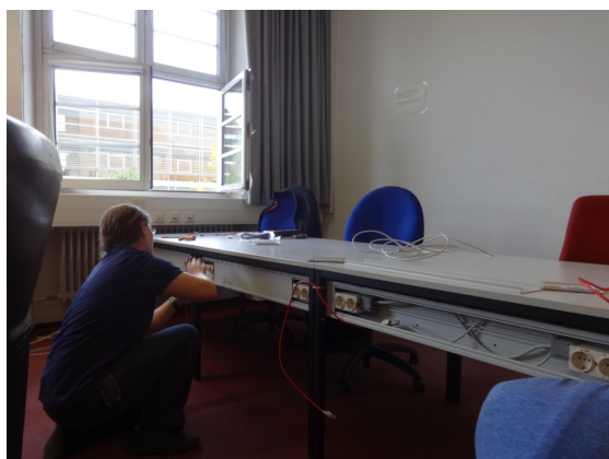
Abbildung 20: Nach Entfernen der alten Lichtwellenleiter verlegen Helma Sendlbeck und Leonhard Hüttinger Kupfer-Netzwerkkabel in sämtliche Kabelschächte und schließen die Kabel an dem neuen Switch an.
