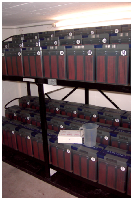
Batterie-Rack im eO-U1
