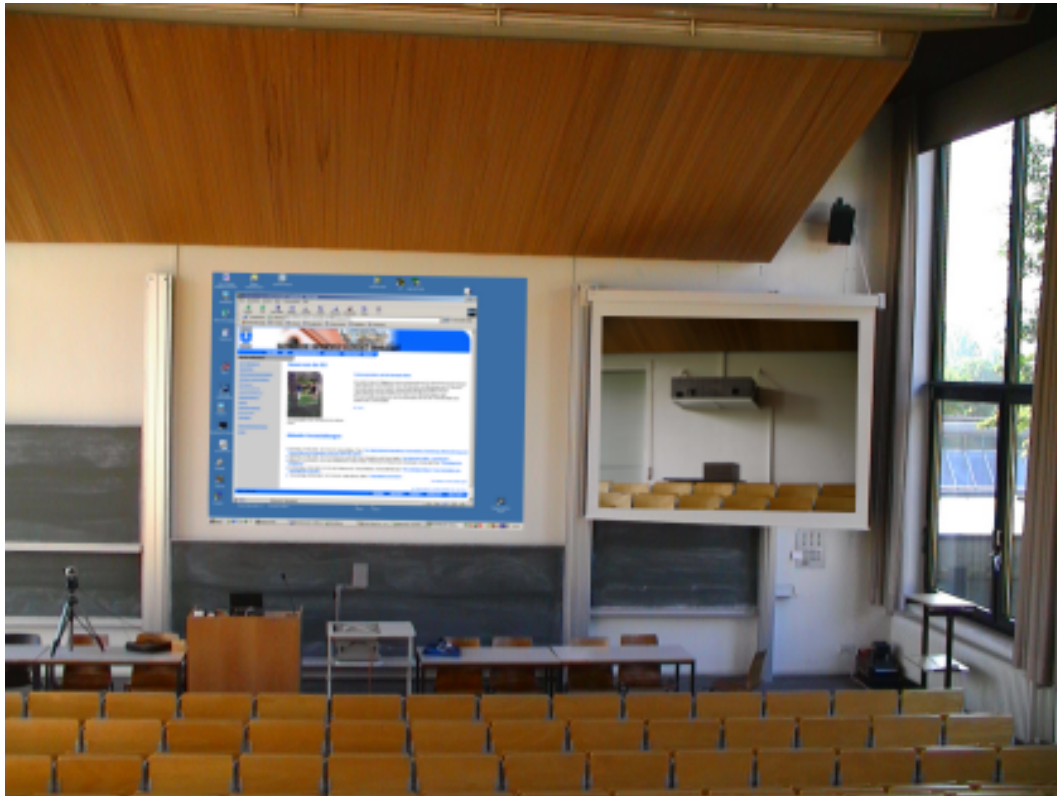
Projektion im Hörsaal KGA-201, auf der rechten Leinwand ist ein Metallkäfig zu sehen, der die beiden Projektoren beinhaltet
